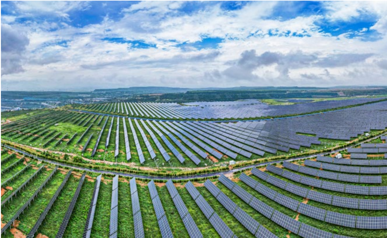
平朔集团 100MW 光伏项目
